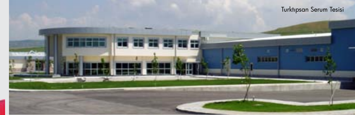
Euronut Gıda Fabrikası
